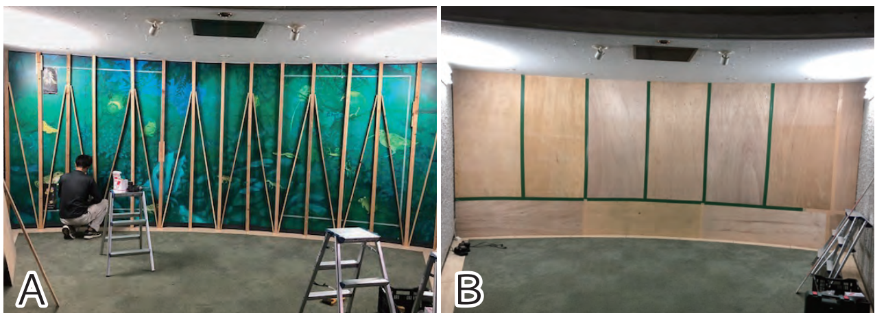
図2 壁面の施工状況 A：木材枠設置状況。B：ベニヤ板により構築した壁面。
