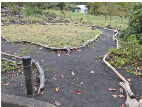
図6 観察路柵施工後の様子
